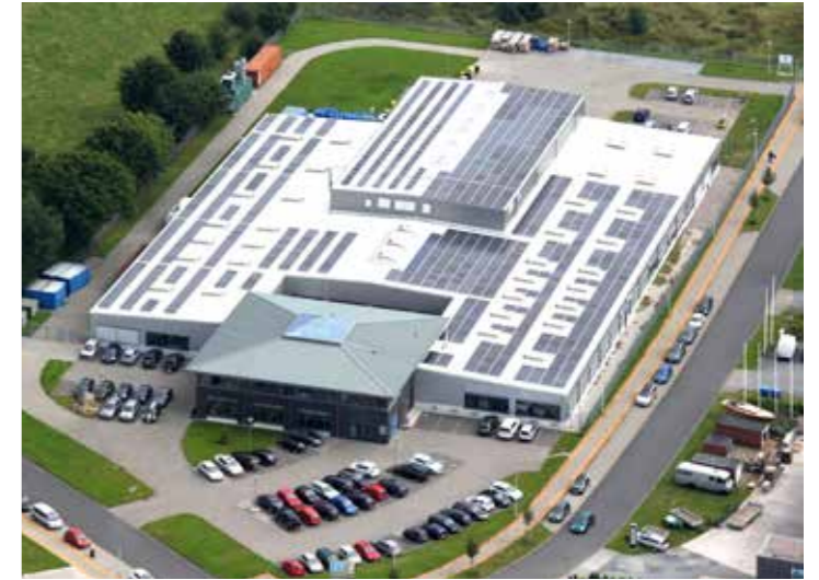
À fin 2024, 11 sites industriels étaient équipés avec des centrales photovoltaïques destinées à l'autoconsommation, comme celui de Husum, en Allemagne.
